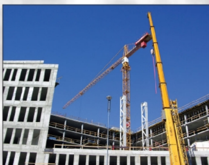
STAVBY ZÁKLADŮ A OBJEMNÉ BETONOVÉ ČÁSTI
