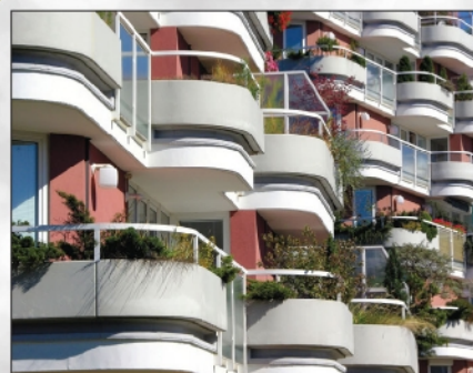
VÝROBA STAVEBNÍCH DÍLŮ
