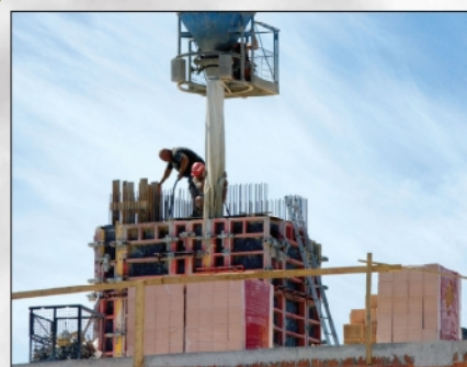
BETONÁŽ PŘI TEPLITÁCH NAD 5 °C
