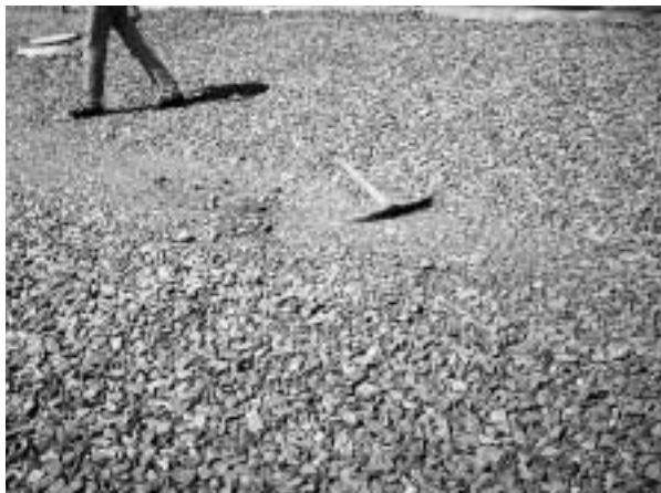
Obr. 1: Znečištěná kostra kameniva znemožňující prolití.
