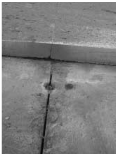
Obr. 4: RWY 13-31, hrana původního betonu, mimoběžné příčné spáry a „odvodňovací“ vrt v příčné spáře.
