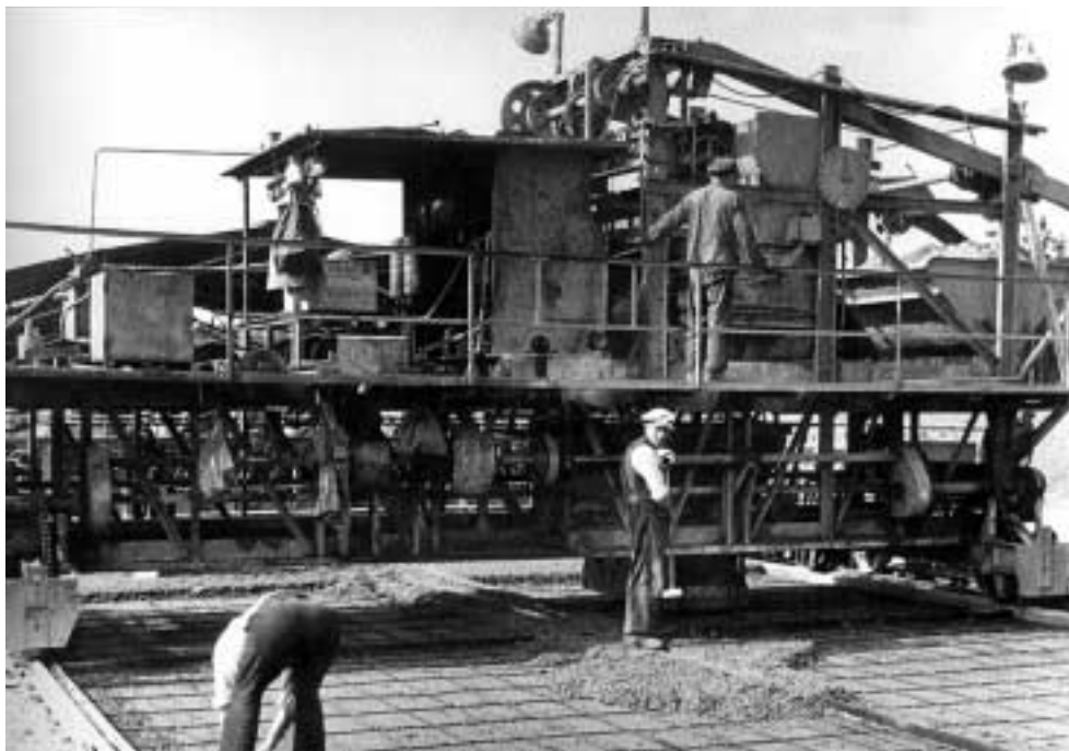
Obr. 2: Dvouvrstvý CB kryt na německé dálnici ve třicátých letech 20. století.
