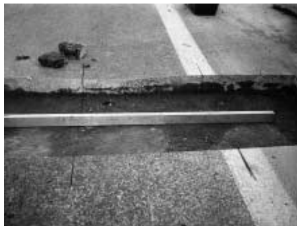
Obr. 4: Tamtéž, zachovaná rovinatost na vrstvě KAPS.
