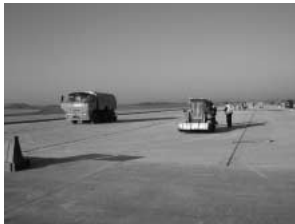
Obr. 9: RWY 06-24, začátek vybouraného úseku, v popředí kryt z roku 1992 s deskami 5 x 5 m.
