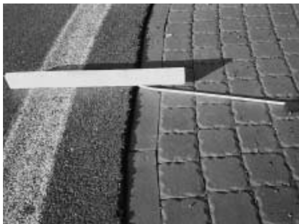
Obr. 11: Rondel ulice Kohoutovy, zima 2000, mrazový zdvih vrstvy 20 mm.
