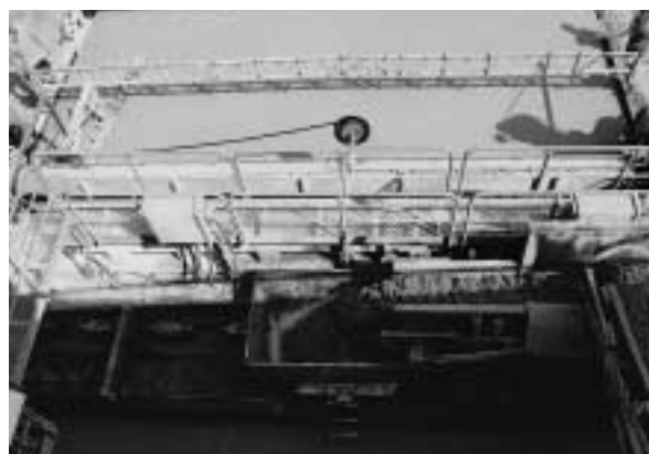
Obr. 5: Rozdělovač betonu pro druhou vrstvu finišerem Wirtgen SP 1600.
