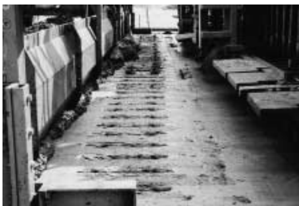
Obr. 4: Po vložení trnů zůstávají na povrchu spodní vrstvy zřetelné stopy.
