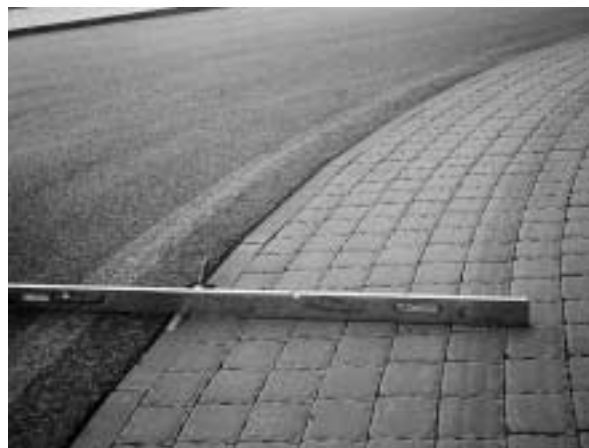
Obr. 12: Tamtéž, podzím 2003 po aplikaci těsnicích pásků.
