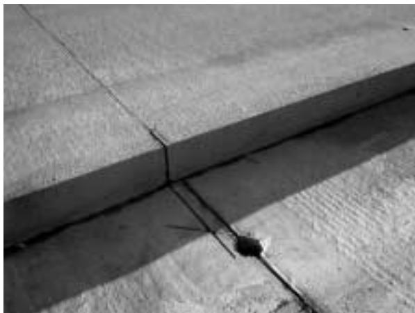
Obr. 10: RWY 06-24, mimoběžné příčné spáry a „odvodňovací“ vrt v příčné spáře, beton perfektní.
