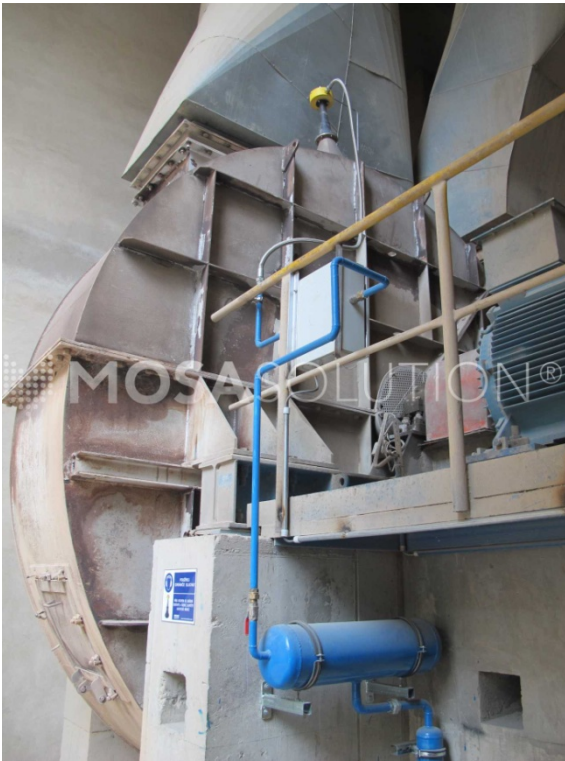
Montáž akustického měniče
